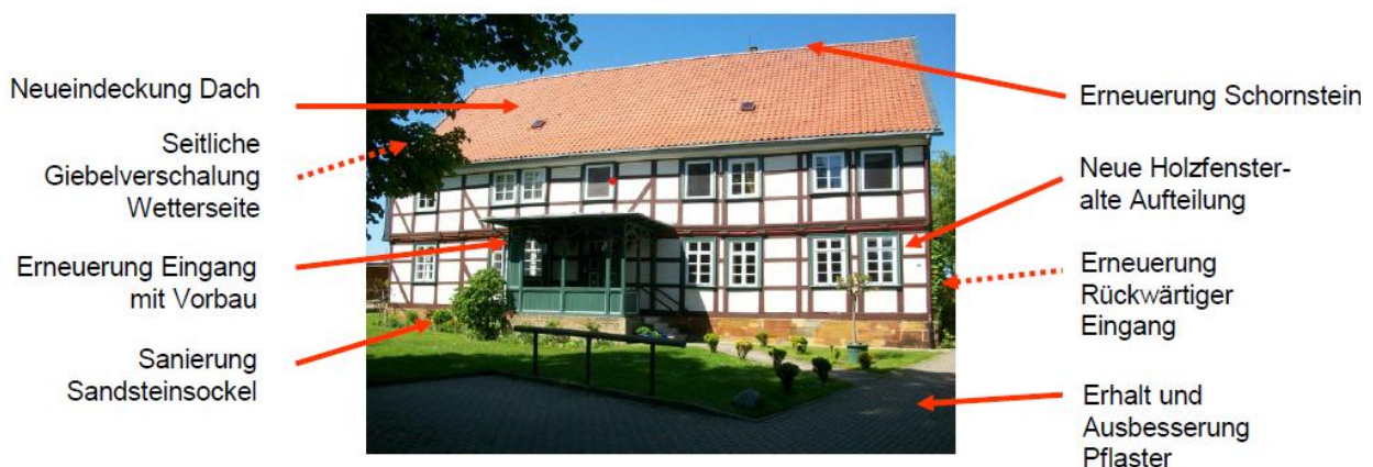
Abb 5 Maßnahmen am Gebäude (Sanierungsbeispiel)
