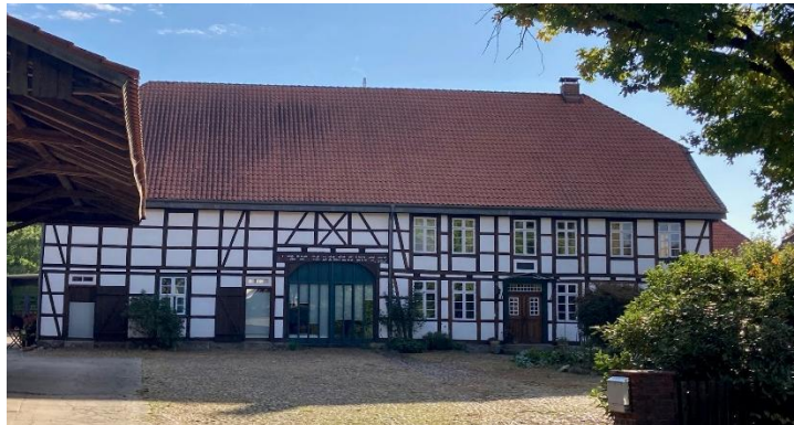
Abb 10 Baudenkmal im Fachwerkstil in Jembke
