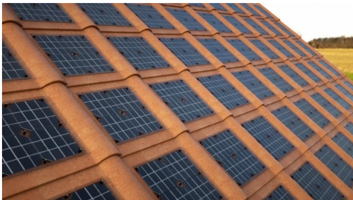
Abb 21 Integrierter Solardachziegel
