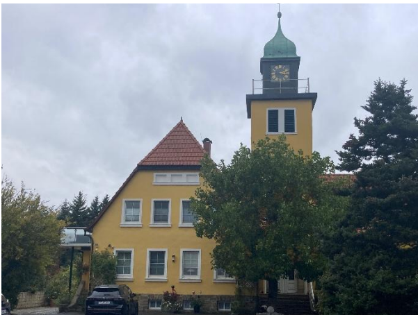
Abb 1 Ortsbildprägendes Gebäude in Hoitlingen
