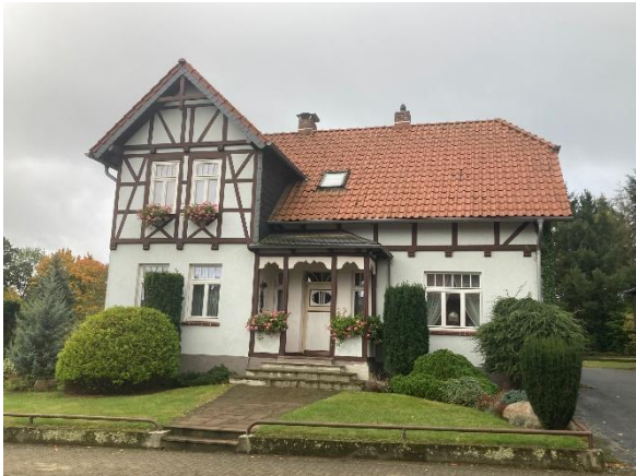
Abb 6 Bedachung mit Hohlziegeln aus naturrotem Ton
