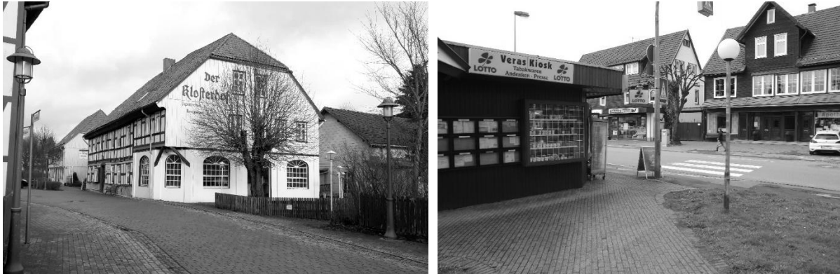
Abb. 15 Beispiel Gaststätte in Betrieb und Versorgungsinfrastruktur
